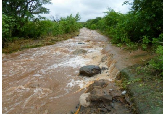
Calle destruida por desborde del Arroyo Bella Vista
