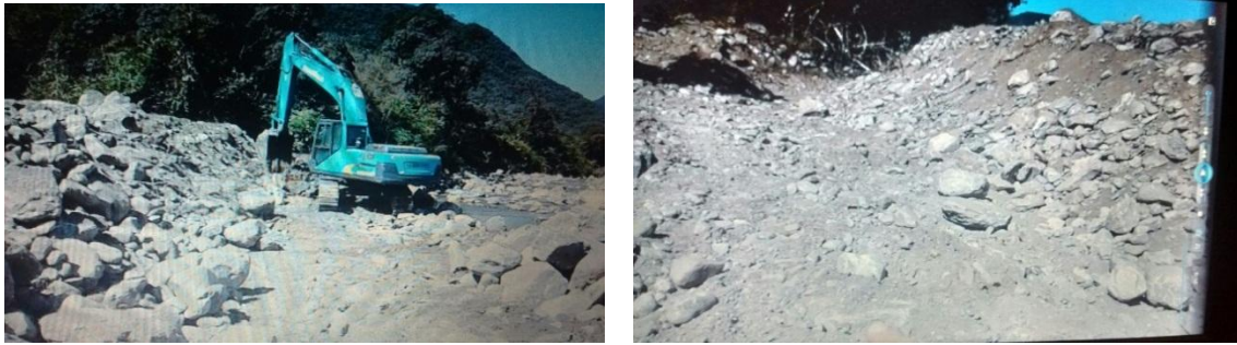
Izquierda máquina construyendo defensa en la margen noreste del Rio La Cañada, derecha, defensa en forma de terraplén vista del lado externo. Segundo punto de desborde de importancia.
